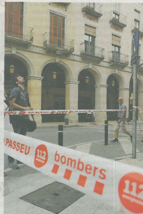
ANÍOL RESCLOSA Una zona acordonada per perill de despeniment.
