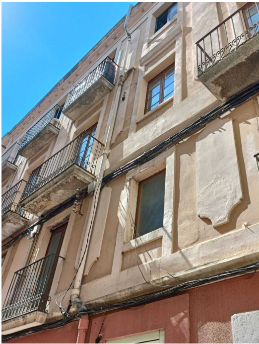
La façana d'un dels habitatges per rehabilitar amb el criteri d'eficiència energètica AJUNTAMENT DE FIGUERES.
