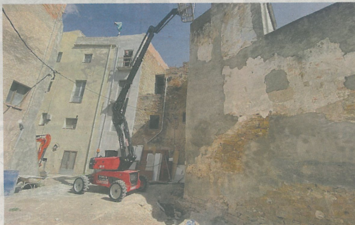
Una grua treballant amb l'enderroc de l'edifici del Call.
