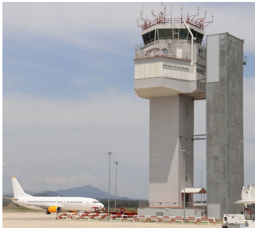
Pla general de la torre de control i un avió aterrant a l'aeroport Girona-Costa Brava ACN.
