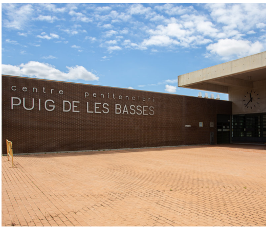
Entrada principal del centre penitenciari Puig de les Basses de Figueres, en una imatge d'arxiu QUIM PUIG.
