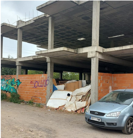
L'edifici ocupat i a mig acabar ACN.
