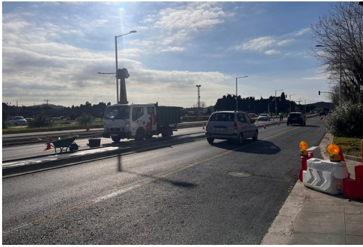
Obres de desdoblament a l'avinguda d'Espanya de Palafrugell. ACN.
