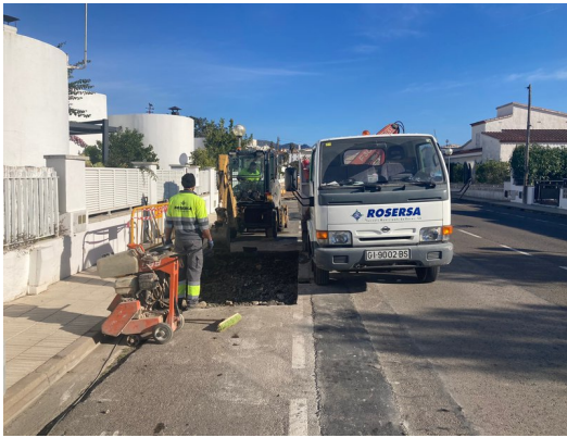
Treballs de preparació AJUNTAMENT DE ROSES.
