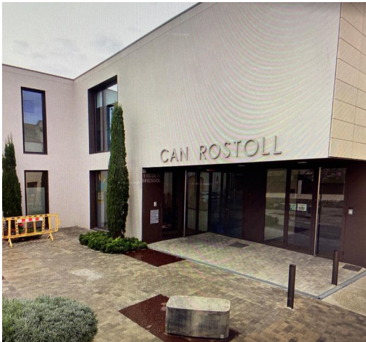
L'edifici de l'escola bressol de Vilabertran EPA.
