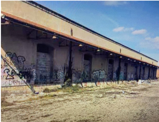
Instal·lacions abandonades d'Adif EPA.
