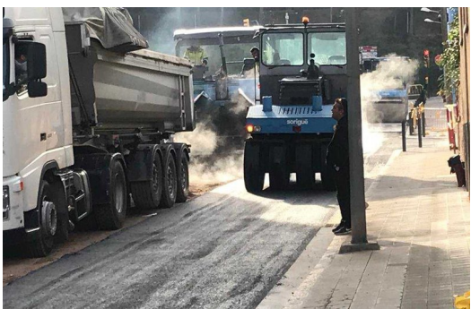
El pla d'asfaltatge es desplega ara en plenitud en el darrer tram de mandat AJ. FIGUERES.
