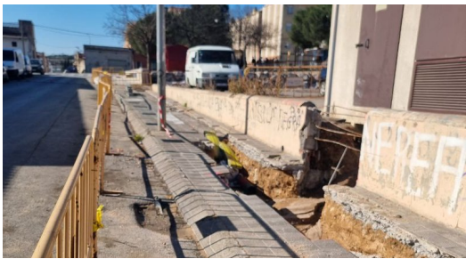
Els treballs de soterrament de línies ja estan executant-se AJ. FIGUERES.
