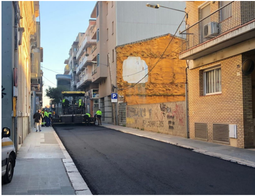
Asfaltatge d'un carrer en una imatge d'arxiu J.T.
