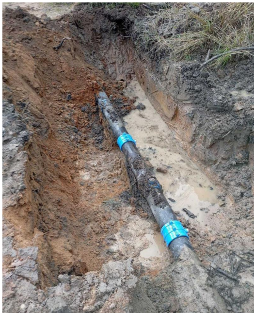
El punt on es va intentar fer una connexió clandestina a la canonada CEDIDA.
