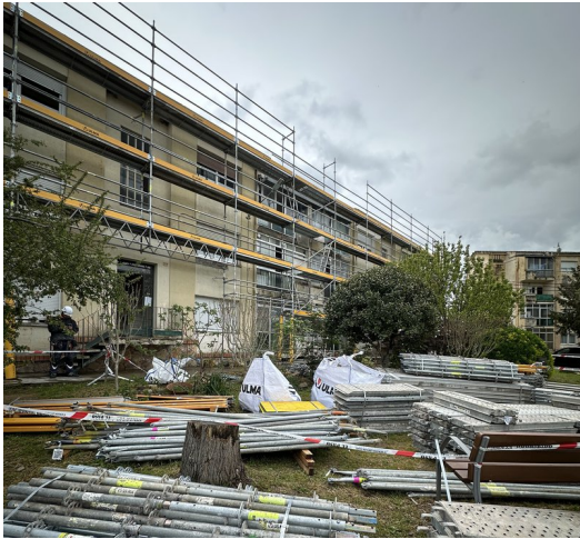
Una bastida en un dels edificis que serà rehabilitat CEDIDA PER L'AJUNTAMENT DE CALDES DE MALAVELLA.
