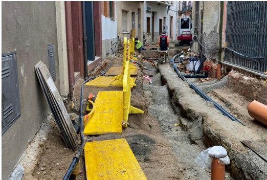
Vista del carrer Major de Caldes en un moment de les obres CEDIDA.
