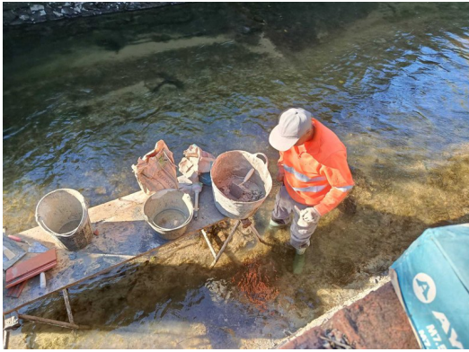
Un operari en els treballs que s'estan fent a la séquia Monar AJ. SALT.
