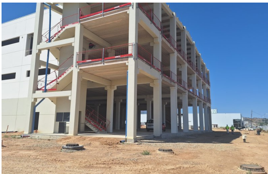
Obres a la planta de Fraga (Baix Cinca), on fan una inversió conjunta de 40 milions en el marc del projecte 'Glicopepton Biotech'. CEDIDA.
