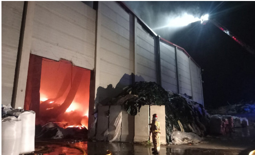
Nau de la planta Ecogironina afectada pel foc BOMBERS.
