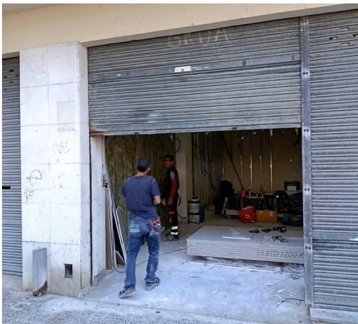
Obres al local del carrer de les Filadores perquè pugui fer-s'hi el nou Centre de Salut i Benestar Emocional Jove AJUNTAMENT DE SALT.
