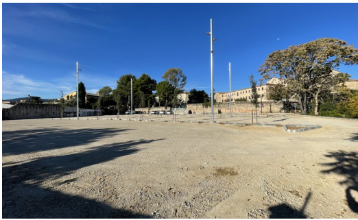
Vista del nou aparcament AJUNTAMENT DE BANYOLES.
