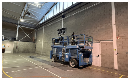
Imatge dels treballs que s'han començat a fer al pavelló firal AJUNTAMENT DE LA BISBAL D'EMPORDÀ.
