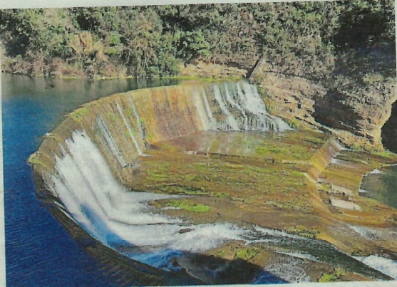
Central de Martís on Agrienergia vol executar millores.
