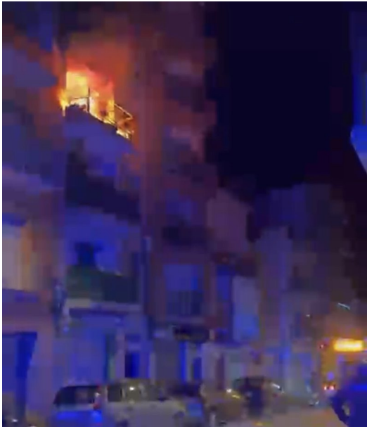
L'incendi a un tercer pis d'un edifici del carrer Tapis GUÀRDIA URBANA FIGUERES.
