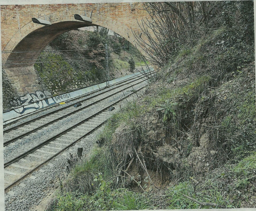
Moviment de terres a l'R11 entre Caldes de Malavella i Girona.
