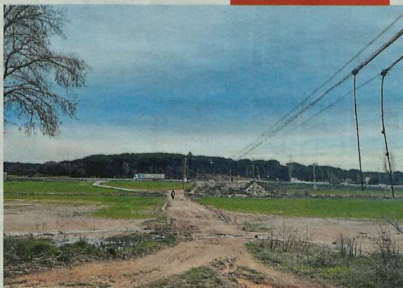
El camí d'accés cap al nucli de Caldes per la nova rotonda, pendent d'executar.
