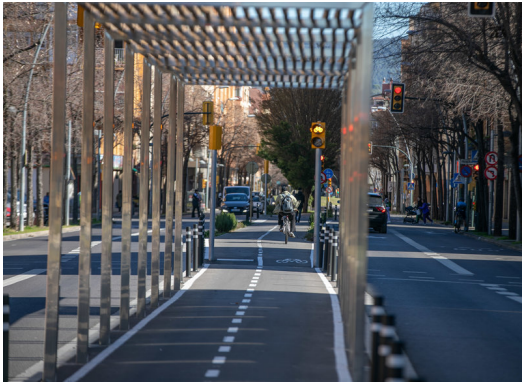
El carril bici del bell mig del passeig Països Catalans de Salt, dilluns, ha estat construït amb motiu del carril bus ràpid BR Cat. QUIM PUIG.
