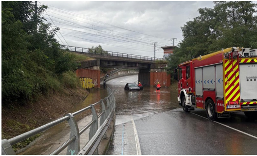
La carretera GI-552, tallada al trànsit a Riells i Viabrea l'any passat a causa de la pluja EL PUNT AVUI.
