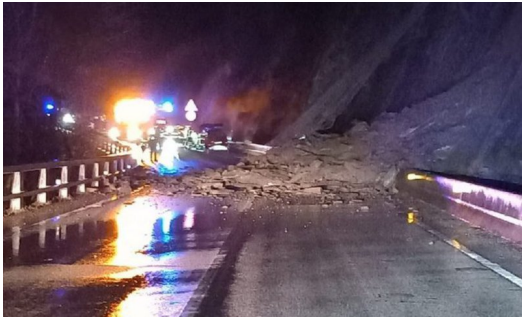
L'esllavissada de pedres a l'N-260 entre Ripoll i Sant Joan de les Abadesses BOMBERS.
