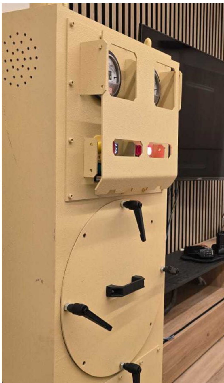
Filtradora NRBQ en un menjador de búnquer ■ T. CASTR
