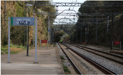
La circulació de trens tallada per un arbre caigut a la via ARIADNA RECHE / ACN.
