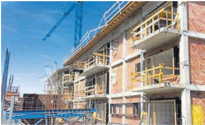
Un edifici en construcció a Bellver
