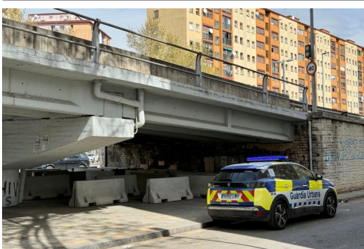
Un cotxe de la Guàrdia Urbana, davant el tram del sotapont on s'hi han instal·lat els blocs Jordi Pujolar / ACN.
