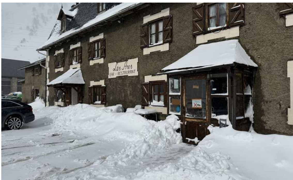
El refugi de les Ares, al Pallars Sobirà, amb neu acumulada pel vent davant de la façana ACN.
