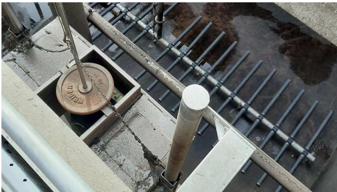
Remplacement des diffuseurs d'air en cours, à 6 m de profondeur.
