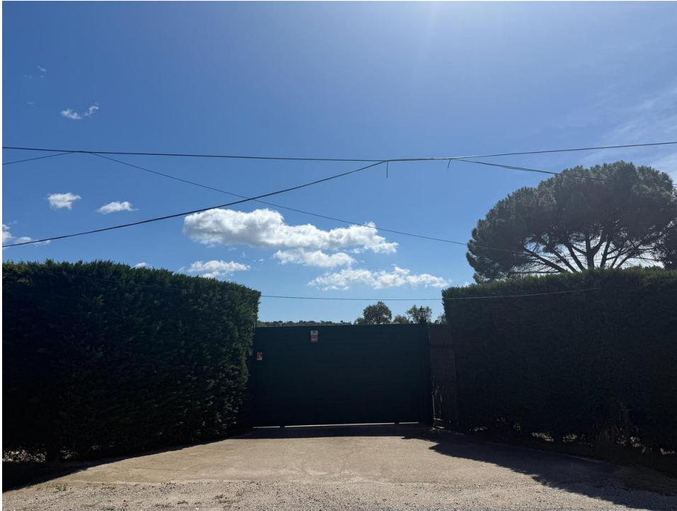
Cables de la línia telefònica i de fibra òptica a la urbanització cassanenca. / DdG
