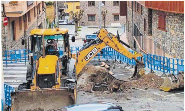
Els operaris treballen per reparar els desperfectes
