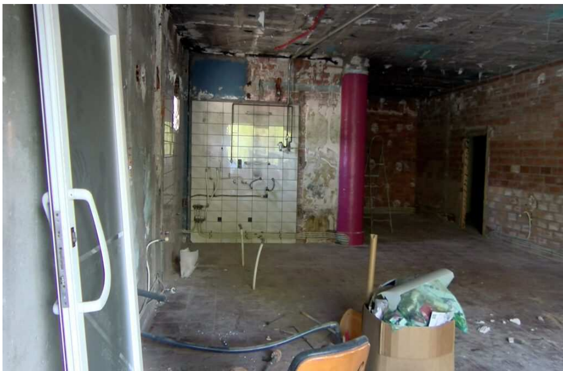
Inici de les obres del projecte de La cuina de l'Adis / M.F.C.
