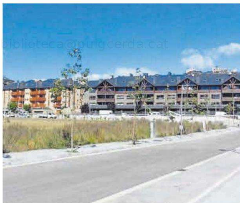
La zona de la Pedragosa on s'han de fer part dels pisos de protecció
