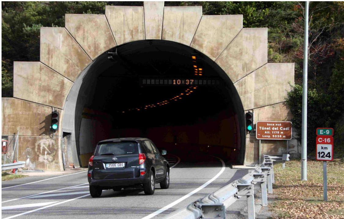
Boca sud del Túnel de Cadí /
