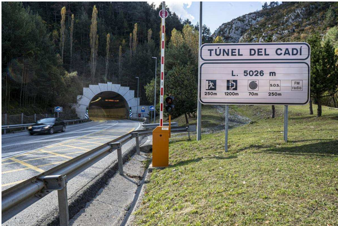
El acceso norte del túnel del Cadí / OSCAR BAYONA
