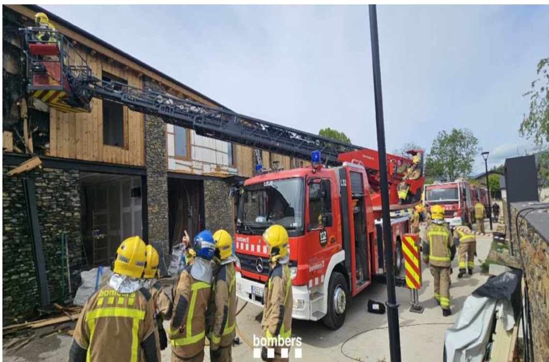
Bombers treballant en l'incendi de la façana a Vilallobent / Bombers
