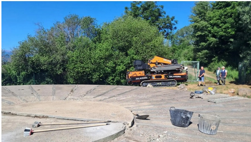
Obres de reparació de la coberta del dipòsit de Cereja / Ajuntament de Llívia
