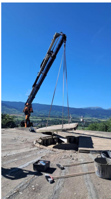
Obres de reparació de la coberta del dipòsit de Cereja / Ajuntament de LLívia
