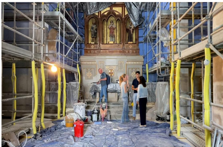
Treballs a l'interior de l'església de Das / E.V.M.
