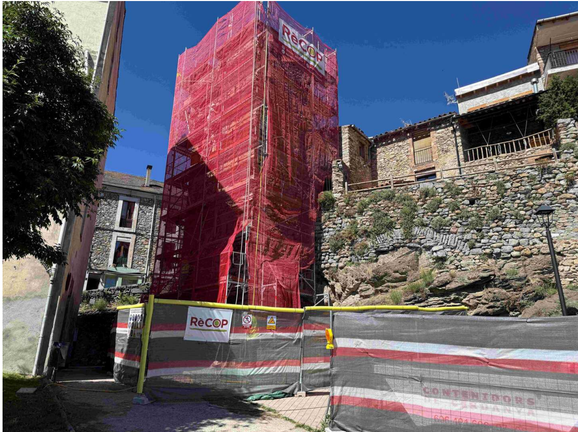
Bellver de Cerdanya inicia les obres de rehabilitació de la Torre de la Presó / Feliu Sirvent
