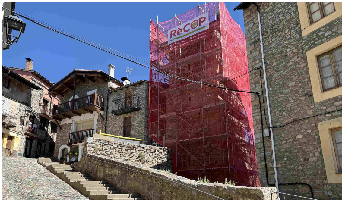
Bellver de Cerdanya inicia les obres de rehabilitació de la Torre de la Presó / Feliu Sirvent
