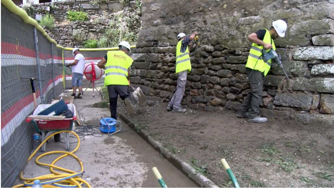
Personal treballant en la rehabilitació de l'espai / M.F.C.
