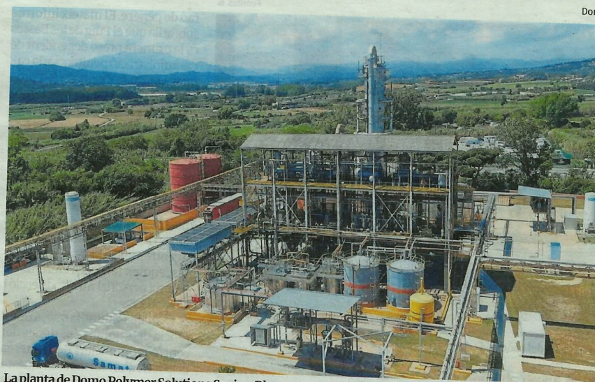
La planta de Domo Polymer Solutions Spain a Blanes.
