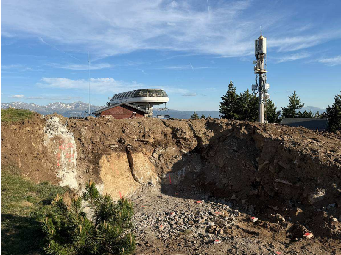
Han començat les obres per a la base del nou desembragable Calma Nord (Foto: IST).
