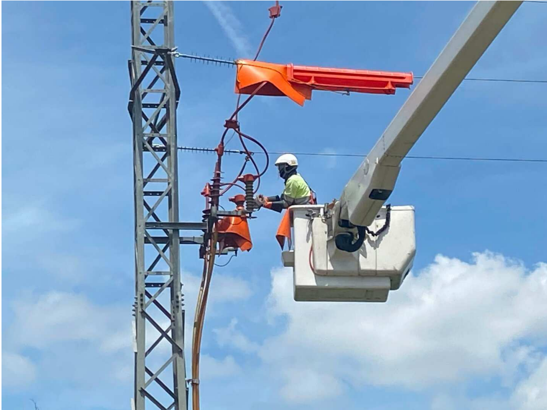
Tècnics substituïnt elements de suport en una línia de 25 kV a Puigcerdà / ACN
