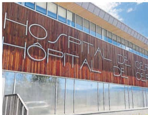
Façana del l'Hospital de Cerdanya, a Puigcerdà
